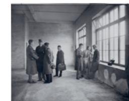
Bauhaus Berlin: Studierende besichtigen die neuen Räume des Bauhauses in der umgebauten Telefonfabrik in Berlin-Steglitz, 1932 Bauhaus-Archiv Berlin, © KEYSTONE Pressedienst GmbH & Co. KG
